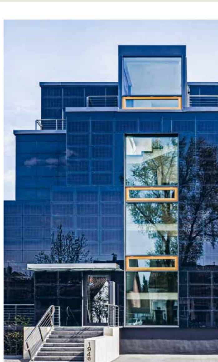
↑ Photovoltaik-Fassaden bei einem Mehrfamilienhaus, wie hier in Bonn, bieten ein großes Potenzial für die Erzeugung von Solarstrom.
