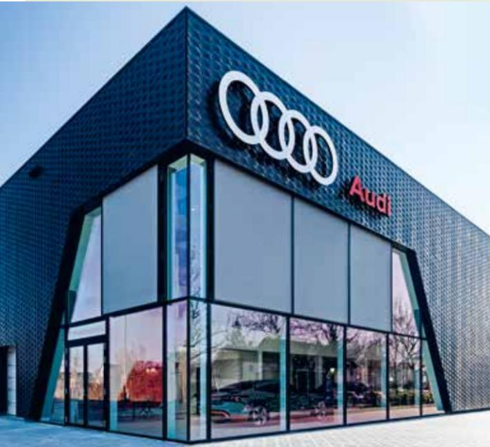
↑ **Fassade als CO<sub>2</sub>-Speicher:** 1.400 Fassadenplatten binden zehn Tonnen CO<sub>2</sub> am Audi Flagshipstore in München.
