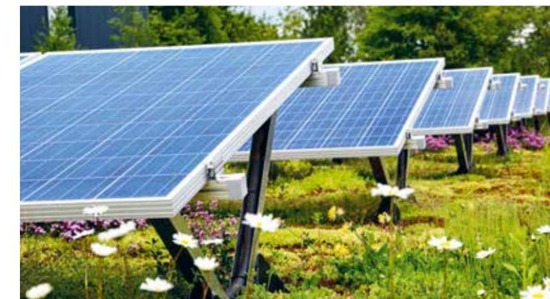
↑ Kombiniert mit Solarzellen, steigern Begrünungen des Flachdachs den Ertrag der Solaranlage um bis zu 20 Prozent.
