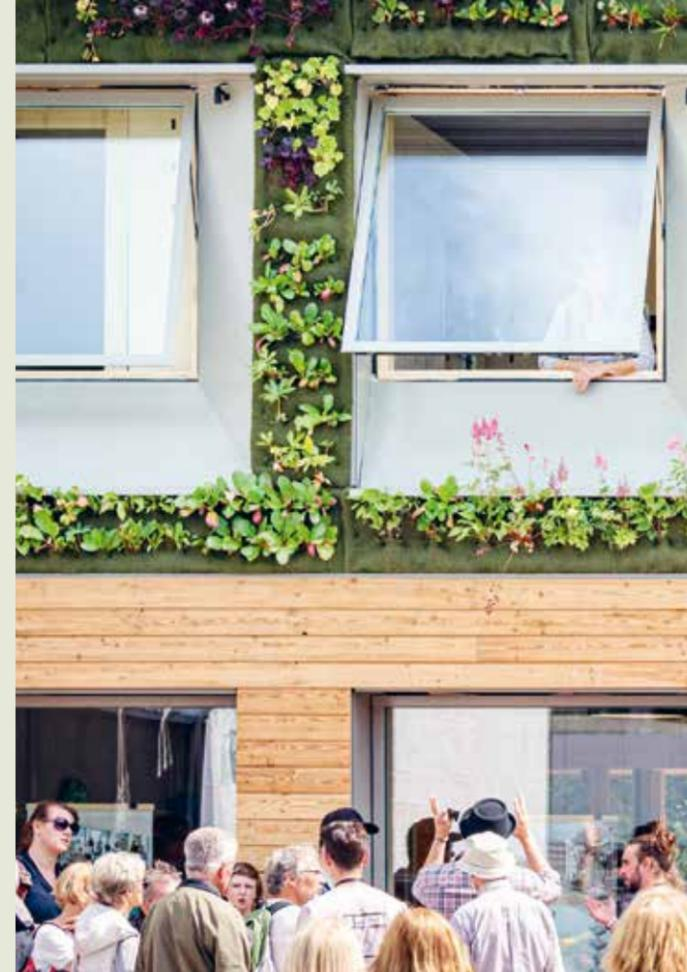
← Begrünungen der Fassade produzieren frische, kühle Luft durch das Verdunsten von Wasser.
